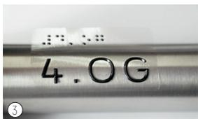
4. Die Braille- u. Taktile Texte sind zusätzlich mit einer Lackschicht überzogen, um sie griff- und tastfest zu machen. Jedoch bietet dieser keinen Schutz gegen mechanische Beschädigungen oder Umwelteinflüsse.
